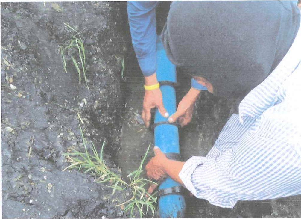
งานติดตั้งประปาชั่วคราว
