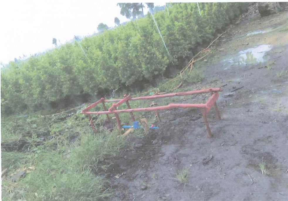
งานติดตั้งประปาชั่วคราว
