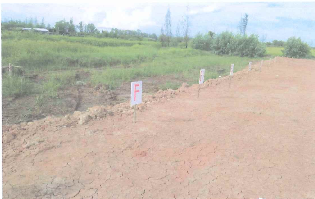
งานปักผังงานก่อสร้าง
