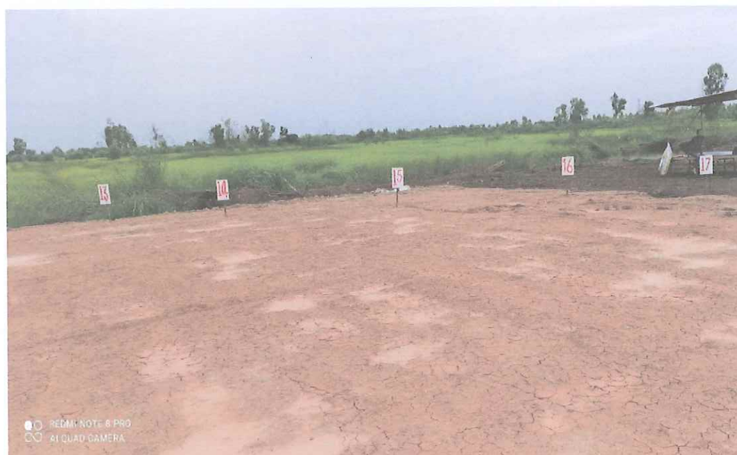
งานปักผังงานก่อสร้าง
