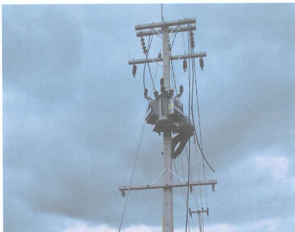
งานติดตั้งหม้อแปลงไฟฟ้า
