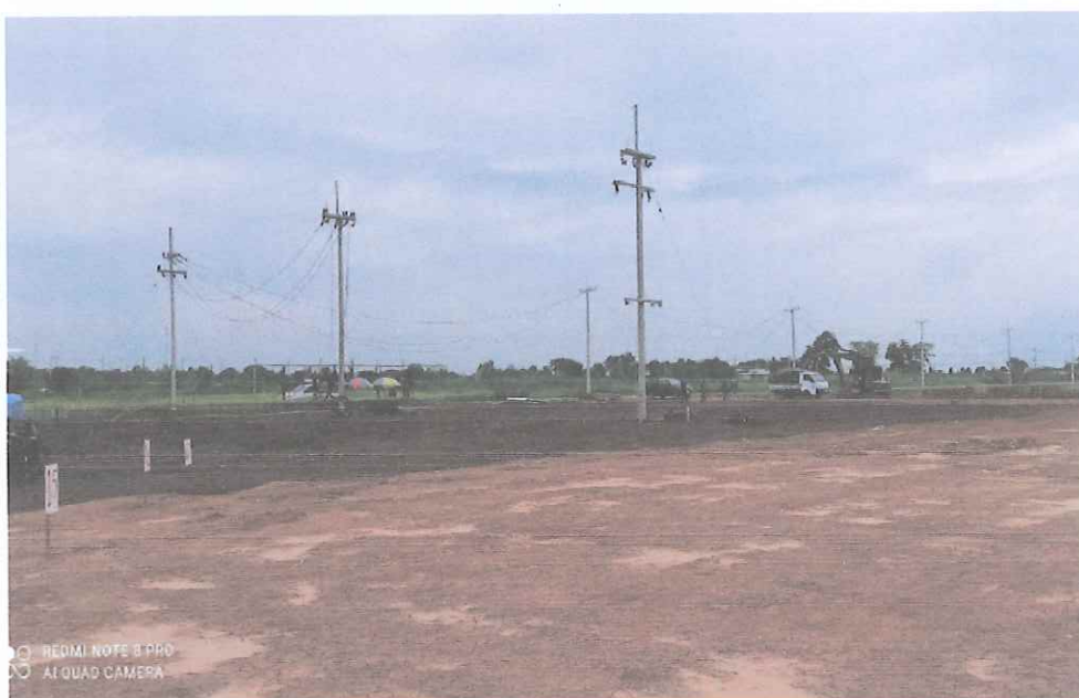
งานปักเสาไฟฟ้า
