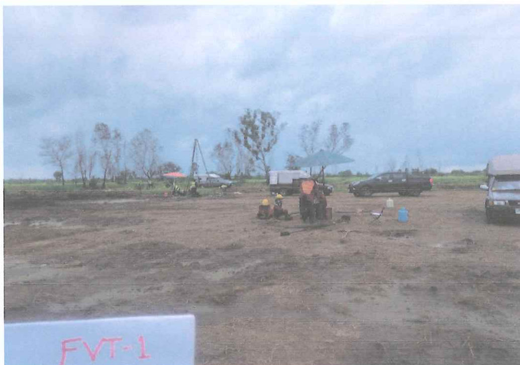
งานเจาะสำรวจดิน
