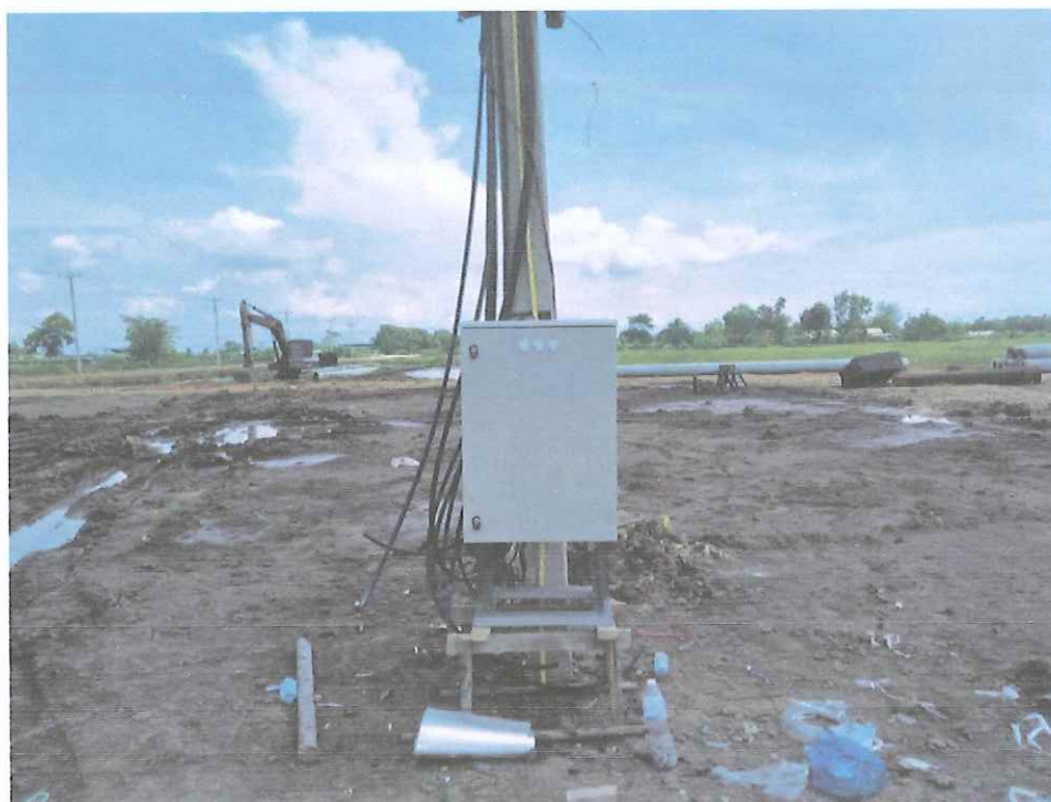
งานติดตั้งตู้ไฟฟ้า
