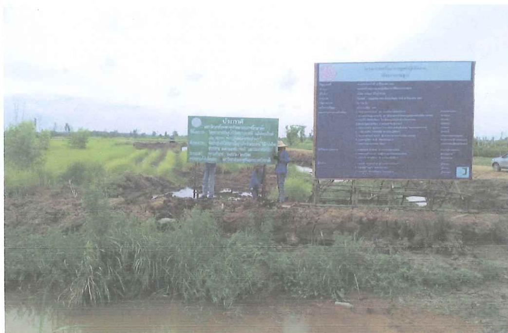
งานติดป้ายประกาศก่อสร้างโครงการ
