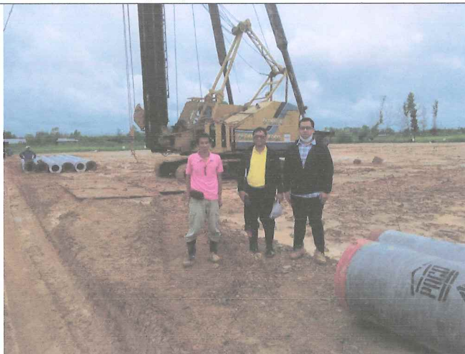
ผู้ควบคุมงานตรวจงานวางผัง
