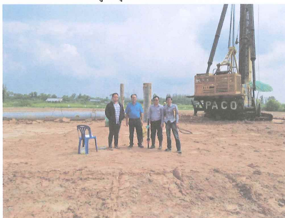
ผู้ควบคุมงานตรวจงานเสาเข็ม
