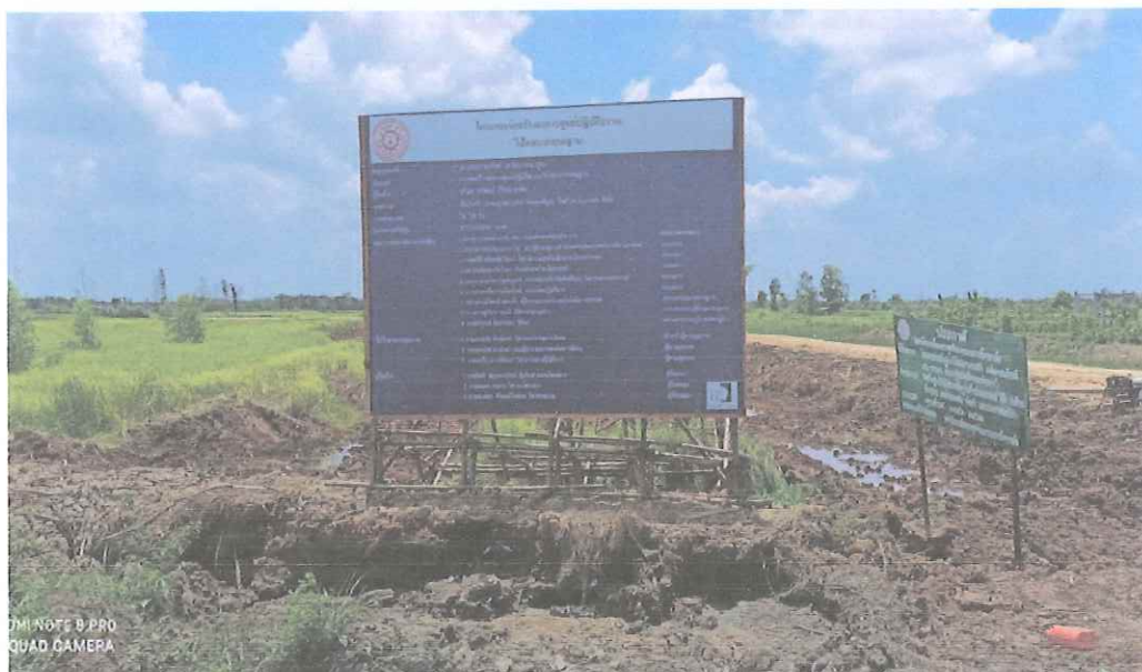
งานติดป้ายประกาศก่อสร้างโครงการ
